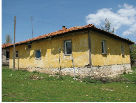
Fotoğraf 3. Yeşilova Köyü, 2 Nolu Oda, Genel Görünüş
